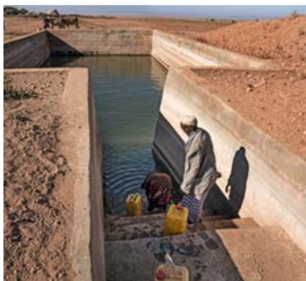
Þar sem djúpt er á grunnvatn og því mjög kostnaðarsamt að grafa eftir brunni eru vatnsþrær sem heimamenn kalla birkur grafnar. Birkurnar eru múrsteinshlaðnar og múraðar tröppur ná niður á botn þeirra. Í birkurnar safnast rigningargvatn yfir regntímann. Vatnið í þeim dugur oft langt inn í þurrkatímann en blanda þarf vatnshreinsidufti í vatnið úr birkunum áður en fólk drekkur það.
