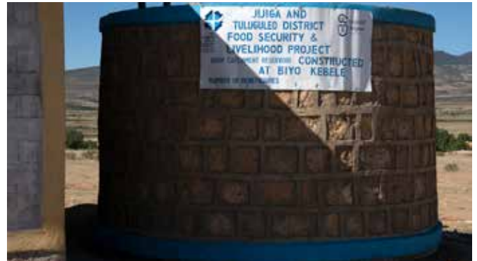
Dýrmætur tími sparast við það að reisa vatnssöfnunartank við skólabyggingu. Tankurinn tryggir nemendum drykkjarhæft vatn á skólatímanum og þeir geta einbeitt sér að náminu.
