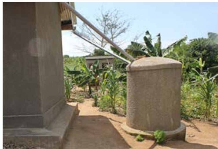
Rennur eru á þökum húsanna og rennur vatn úr þeim í tanka sem reistir eru hlið húsanna. Vatnið í tönkunum dugar fjölskyldunum langt inn í þurrkatímann.
