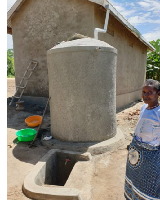
Við hlið múrsteinshússins er reistur vatnstankur fyrir regnvatn sem safnað er af þakinu með rörum og rennu yfir í tankinn. Nágrannarnir njóta einnig góðs af tankinum og er það ein af forsendunum fyrir því að aðstoðin gengur svo vel sem hún gerir.
